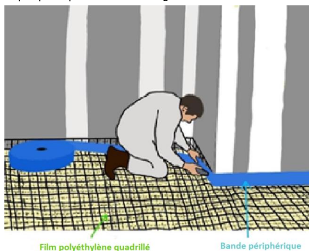
Figure 3 : Réalisation de la désolidarisation périphérique après la pose d'un film de polyéthylène (polyane)
